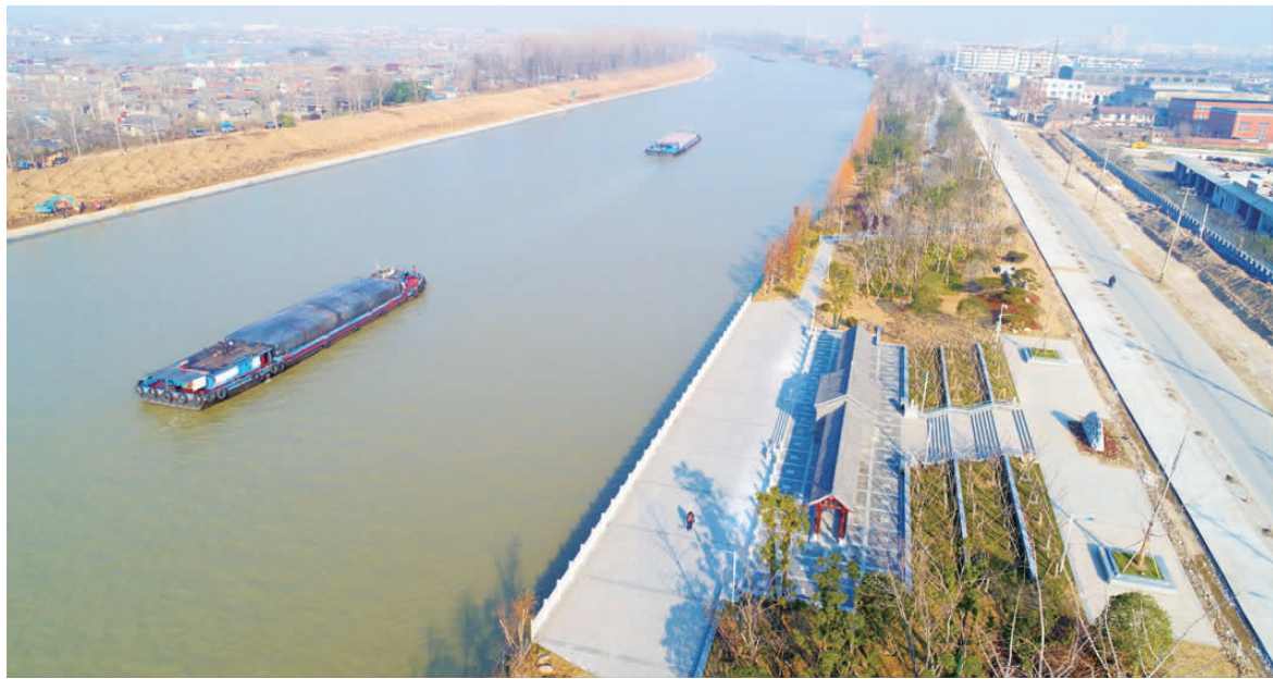
运河文化体育公园北起自来水厂取水口,南至跃进洞,有绿化3万多平方米、各类园路1.5公里、广场3座、亭廊轩1处以及游船码头3处,目前已对外开放。公园的建设既美化了运河航道、对取水口水源地起到了保护作用,又为广大百姓增添了一个健身、休闲的好去处。
