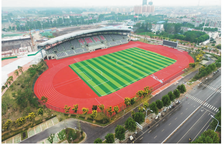
县体育场位于县城水家湖,项目占地71000平方米。包括400米标准室外跑道一条,约4000座的风雨看台,4个标准篮球场等体育运动设施及道排、照明、景观、附属工程。目前项目已完工,即将交付使用。(孔根龙 程奇)
