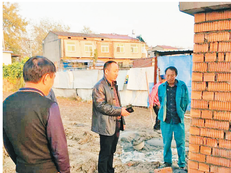
现场督察改厕施工
