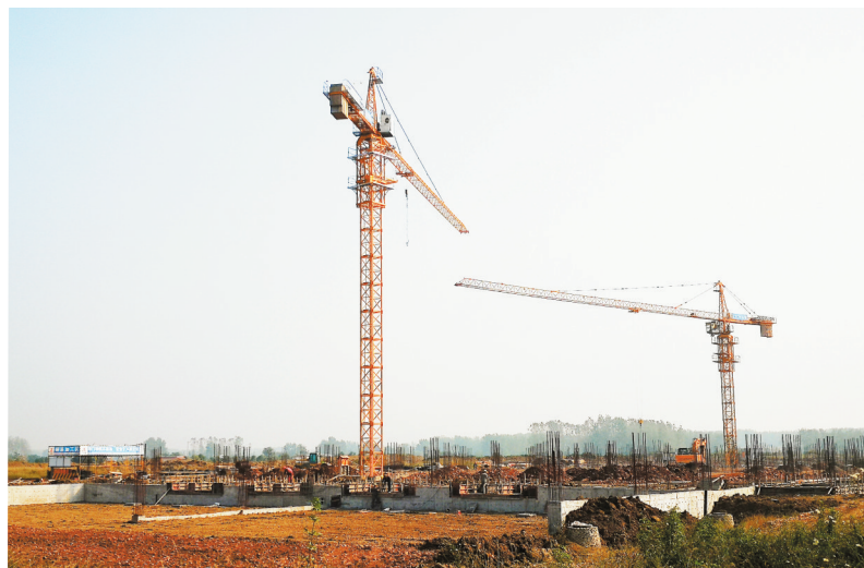
今年以来,以“项目落地推进年”为统揽,各乡镇区持续强化“一切围绕项目干”,全面发力,亮点纷呈。图为下塘镇年产50万套木门及定制化家居配套生产能力的志邦木业配套产业园项目建设现场。(杨维礼)
