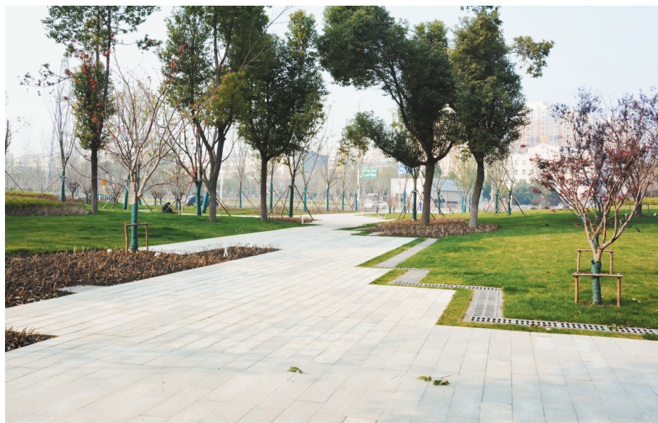
县城长合路综合提升绿化改造项目是县城绿化全面提升项目之一,目前进展顺利,园建部分已基本完工,图为建好后的街头公园一角。(戴磊)
