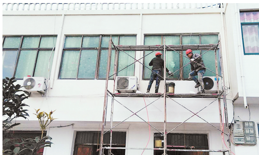
工人正在立面美化施工
