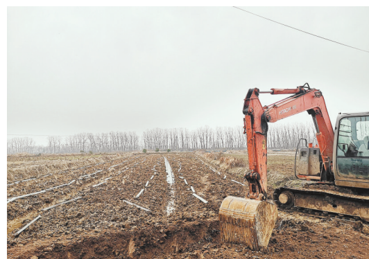
瓜蒌种植基地施工
