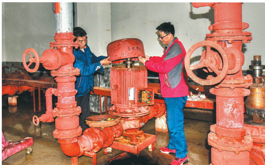
夏季来临,为有效消除消防隐患,县城多个居民小区实施消防设施隐患大排查,对老旧消防设施进行及时更新,同时加大消防安全宣传,提升居民消防安全意识。图为中央花园小区合肥鼎福百居物业正在进行消防水泵更换。(孔根龙)
