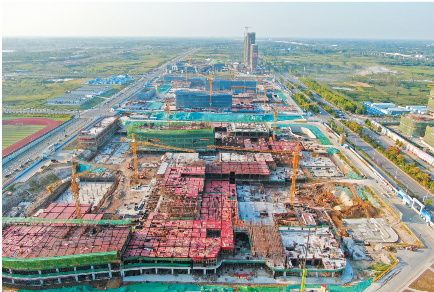
近日，记者从县重点工程管理中心获悉，位于北城的中科大一附院北区建设正在紧张进行中，目前该项目地下室主体结构完成60%，单体楼施工已至四层。(融媒体中心 孔根龙 摄)
