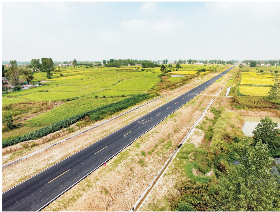
蒙城北路北延项目2标段主路及附属工程已完成,其他标段进入面层施工阶段。预计,今年10月底前,项目主体工程将全部完成,具备通车条件,该项目建成后将大大缩短南部乡镇到县城的距离,同时又增加一条县城通往北城、合肥的快速通道,带动沿线乡镇区域经济建设。(融媒体记者 陈忠摄)
