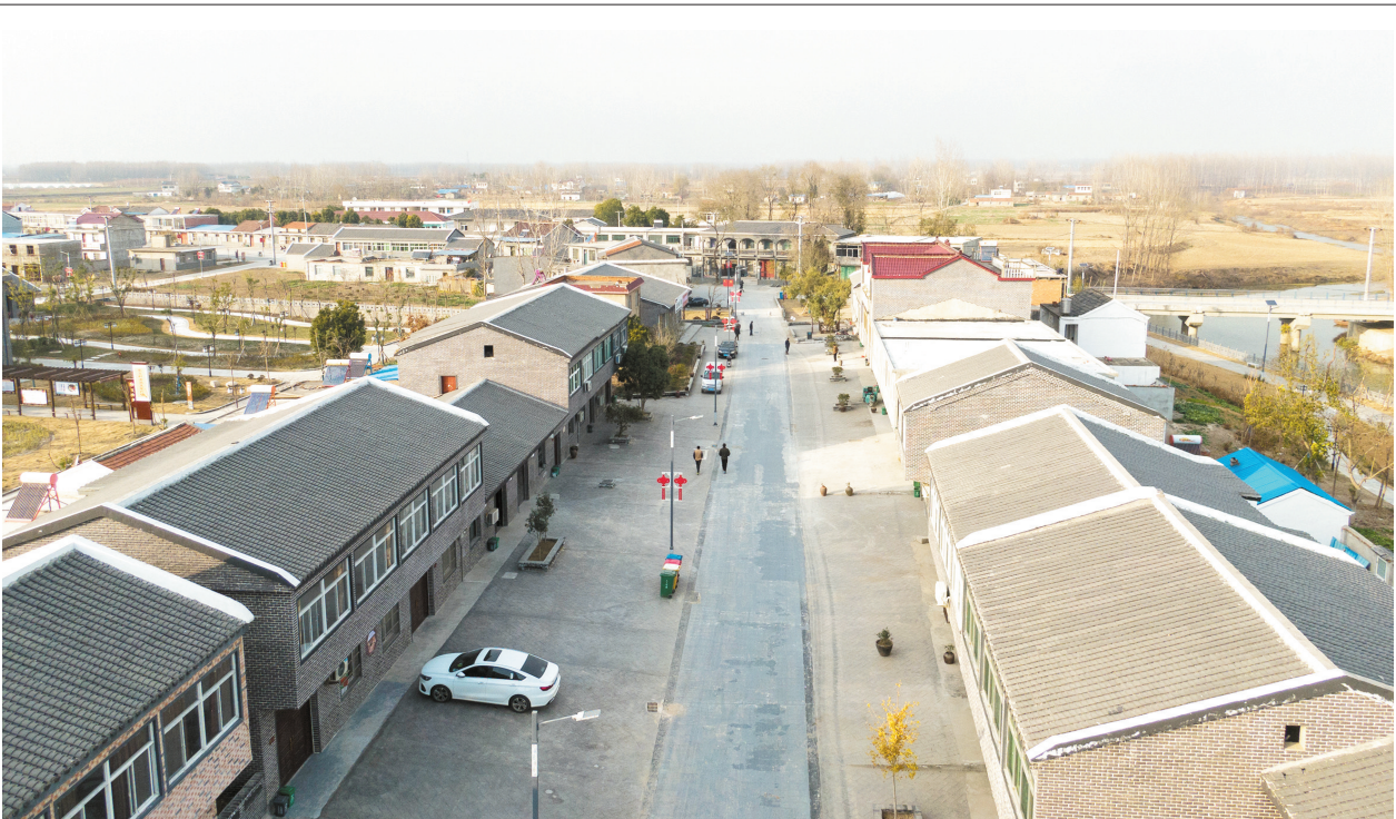
重现古村落昔日的繁华,展现车王村新面貌。车王村千年古村落整治工程和车王村美丽乡村建设项目建设正在持续推进中,部分项目已建成。图为修整一新的集市街道。(融媒体记者 陈忠 摄)
