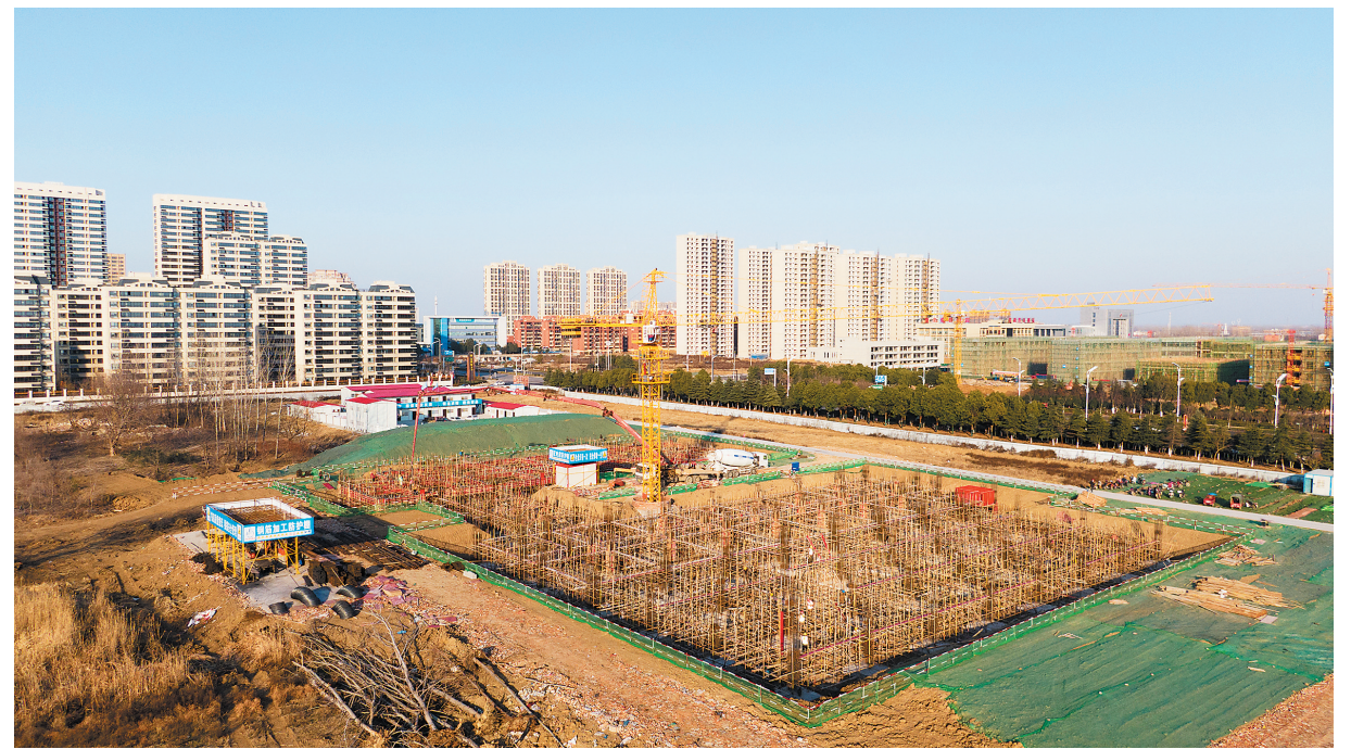
安徽建工技师学院长丰校区建设项目,计划总投资约6亿元,位于水湖镇杨公路与二环路交口。目前,一期建设项目宿舍楼、食堂、教学楼、实训楼等正在进行地基施工。(融媒体记者 陈忠 摄)
