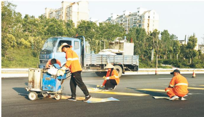
4月25日,施工工人们正在为罗塘路画交通标志标线。水湖镇罗塘路基础设施建设项目日前正式投入使用。罗塘路总投资1.7亿元,道路全长约2公里,红线宽度30米,南北走向,属城市次干道,将大大提升县城西部地块交通通行能力。(融媒体记者 张文摄)
