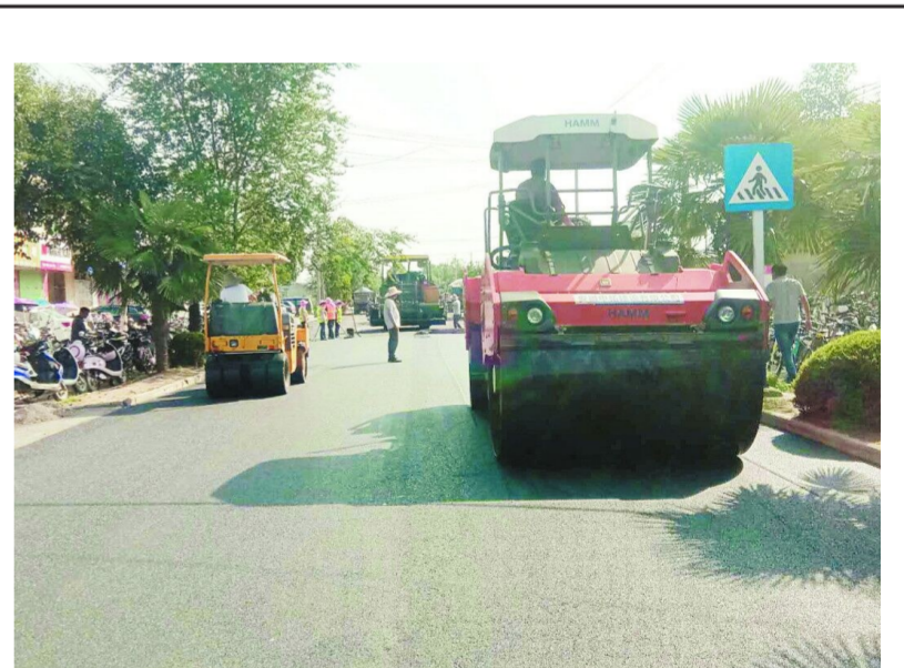
近日,县市政站昼夜加班对水庄路城关中学段路面进行翻修铺设沥青路面,更好地方便中高考考生和周边居民出行。经过4天加班加点,完成600米水庄路沥青路面维修,面积约5000平方米。(融媒体中心记者 杜刚摄)
