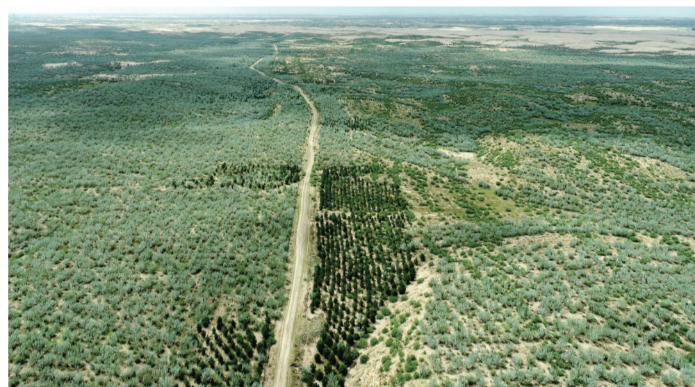
▲翁牛特旗罕都线综合治理工程。
