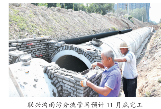
联兴沟雨污分流管网预计11月底完工
