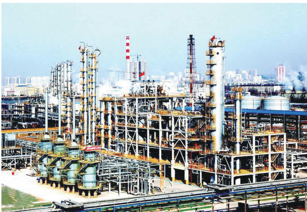
陕西延长集团10万吨/年合成气制乙醇工业示范项目(3月8日摄)。3月17日,记者从中国科学院获悉,一套煤基乙醇工业化项目已经在我国投产成功,这是新型煤化工产业化技术应用的又一次重大突破,将为我国煤炭清洁利用和能源安全提供有力保障。据了解,采用中科院大连化学物理研究所和陕西延长石油集团共同研发的、具有我国自主知识产权技术的煤基乙醇工业化项目——陕西延长集团10万吨/年合成气制乙醇工业示范项目于1月11日打通全流程,生产出合格的无水乙醇,目前该工业示范装置已平稳运行两个月。新华
