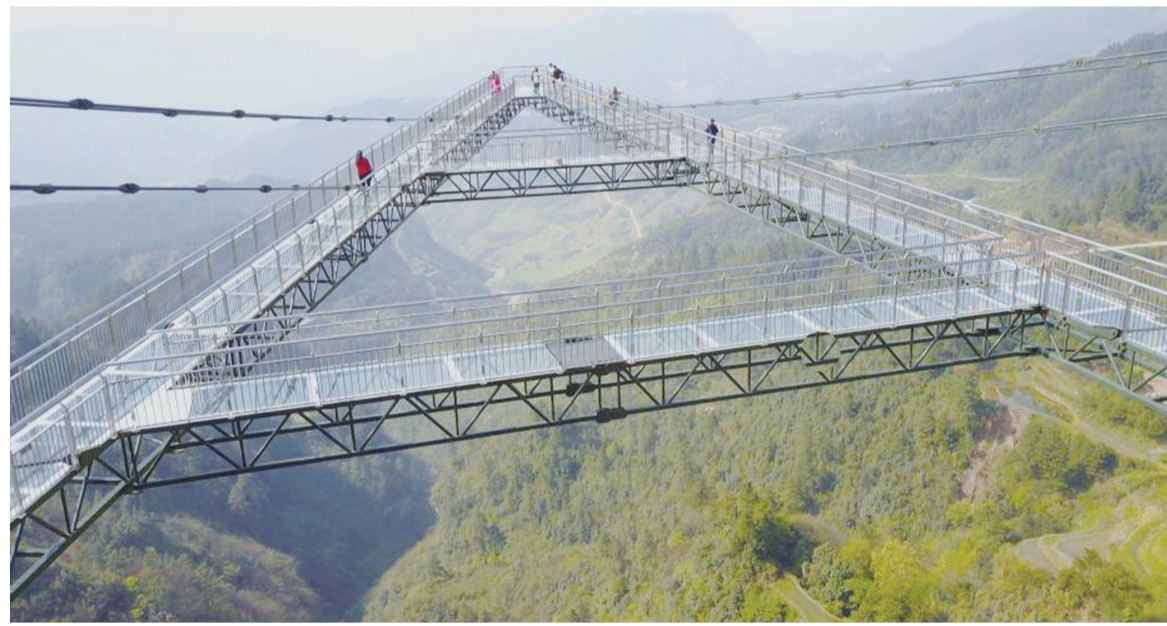
4月6日,重庆一景区内“天空悬廊”吸引了众多市民前往体验。悬廊成“A”字形,桥面铺设全透明玻璃,由于悬空于近300米高的悬崖峭壁之上,又沿悬崖向外延伸在80米的空中,因此取名为“天空悬廊”。相比美国科罗拉多景观廊桥向外悬挑21米,天空悬廊向外悬挑80米更为惊险刺激。目前,该项目正在申请吉尼斯世界纪录。新华
