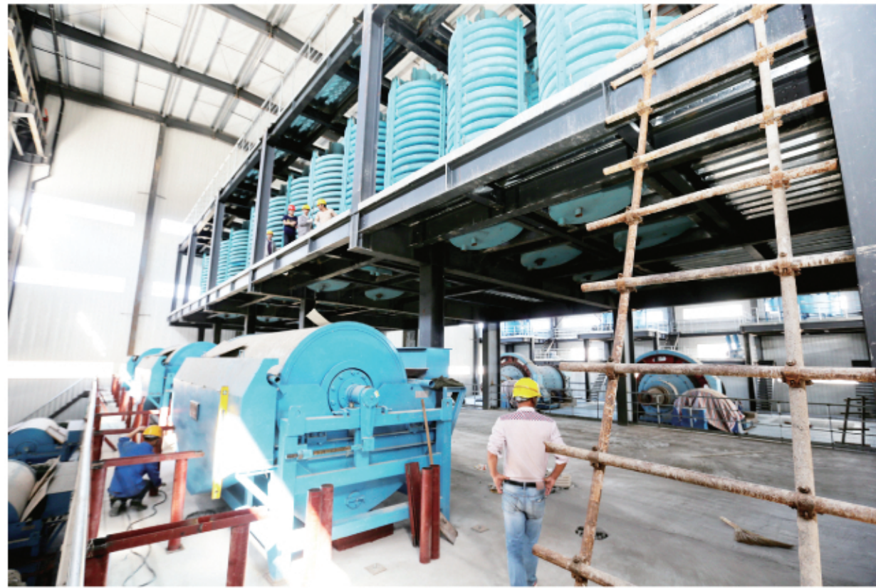
近日，位于港区特钢新材料产业园内的新安德矿业建设现场，工人们在紧张施工。据悉，该公司厂房主体已基本建成，机器设备也在同步安装，计划7月底投入使用。一期工程将建成年处理350万吨的选矿厂和年处理65万吨的焙烧体系，4条生产线全部投入生产后，预计销售额达20亿元，利税2亿元。胡金波 摄
