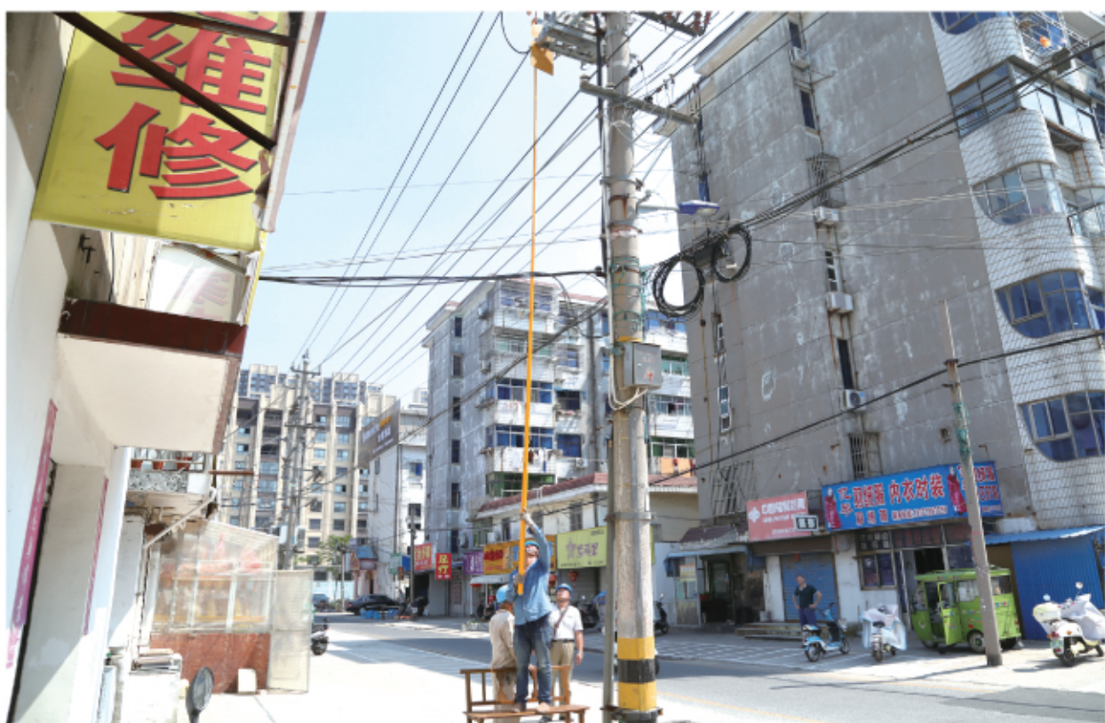
7月23日,供电公司电力工人正在育红小区进行电力抢修。据悉,当天凌晨因故障导致该地段停电,为不影响居民正常生活,电力工人冒着酷暑进行抢修。
