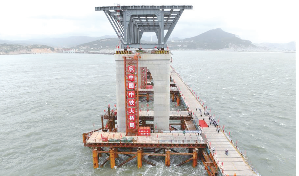
这是8月22日拍摄的庆祝活动现场。当日,中铁大桥局在平潭海峡公铁两用大桥施工现场举行仪式,庆祝平潭海峡公铁两用大桥首孔钢管桁架梁架设成功。平潭海峡公铁两用大桥首孔钢管桁架梁长80米、宽35.5米、重达1350吨,由“大桥海鹰号”起重船担负吊装作业。平潭海峡公铁两用大桥起于福建省长乐市松下镇,经过四座岛屿后到达平潭岛。大桥全长16.34公里。
