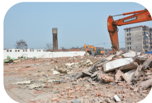
原淮南纱厂老厂房拆迁
