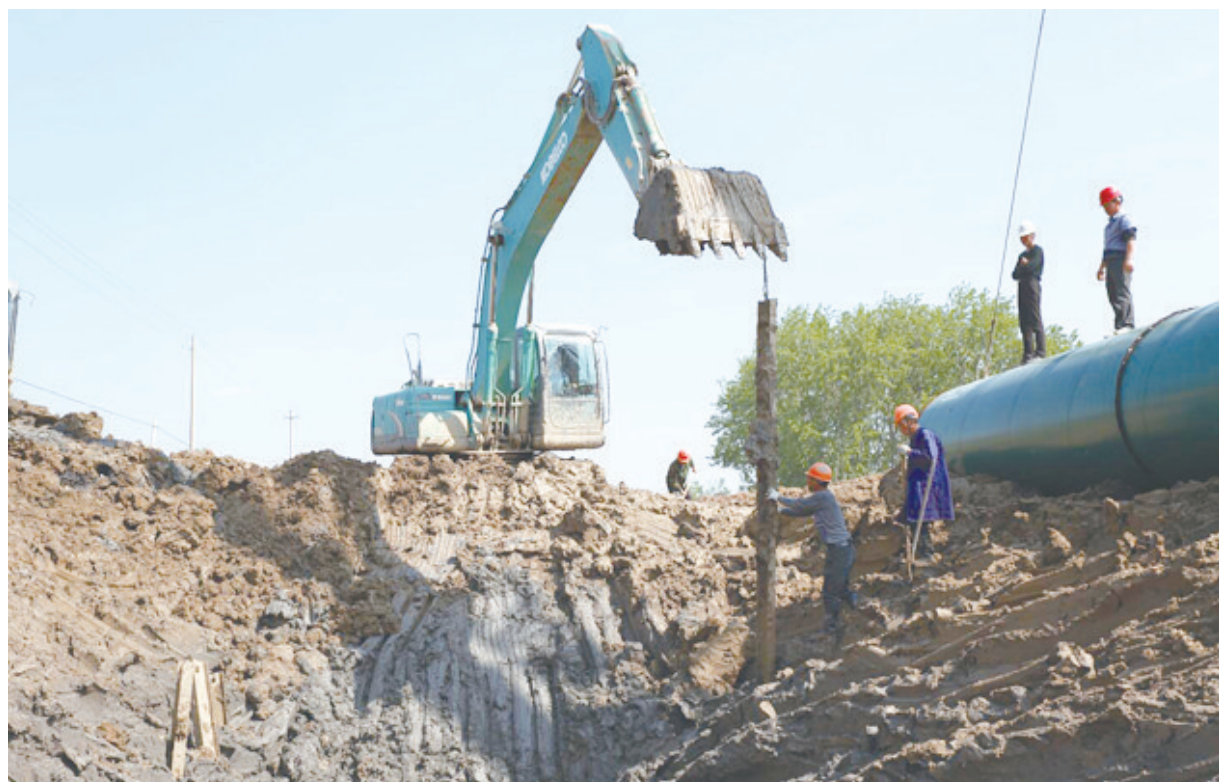
6月11日,盐城新水源地及引水工程大丰支线项目刘庄镇友谊村项目现场一派繁忙景象。目前,大丰支线已完成管道铺设25.486公里、沉井31座、顶管3.436公里、管桥48座、倒虹5座;大丰调蓄水池完成土方35.7万方,11258根桩基全部完成,取水口头部完成基坑开挖,正在准备浇筑。万成 石伟丰 摄
