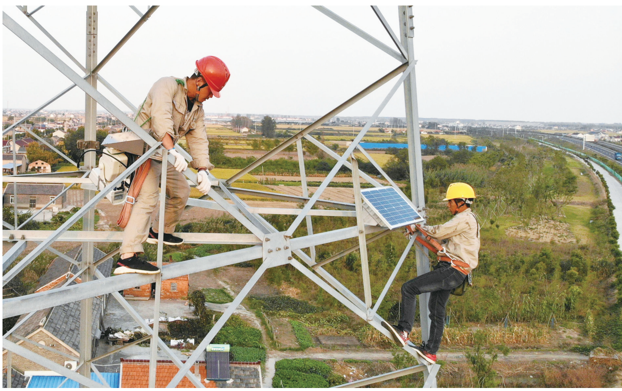
10月12日,区供电公司输电线路运维人员在220千伏东映线48号-49号跨越沈海高速安装视频监控摄像头,进一步提高架空输电线路跨越高速铁路、高速公路和重要输电通道区段的安全运行水平,确保“三跨”和被跨越物的安全稳定。 万成 唐建军 摄
