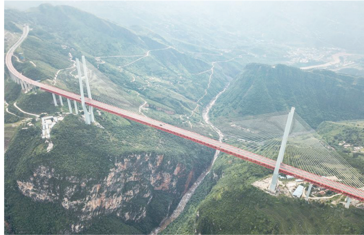
位于贵州、云南交界处抗瑞高速上的北盘江大桥(8月10日无人机拍摄)。其桥面至江面565.4米的垂直高度,被吉尼斯官方认证为“世界最高桥”。世界桥梁看中国,中国桥梁看贵州。作为中国唯一没有平原的省份,贵州在喀斯特高原上架起2万余座桥梁,创造了数十个“世界第一”。世界高桥前100名中,46座在贵州。改革开放40年来,数代建设者铸就“桥梁精神”,打造了数量多、类型全、技术复杂、难度极大的“桥梁博物馆”。(新华)
