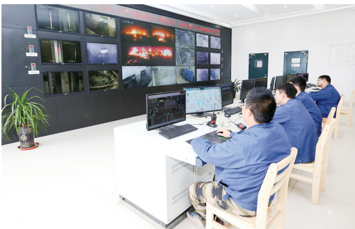
5月30日,江苏大吉环保能源大丰有限公司监控室,工作人员对垃圾焚烧车间进行实时监控。该公司位于草庙镇静脉产业园区内,对我区及周边城市的生活垃圾进行资源化、减量化和无害化处理的同时,实现垃圾焚烧发电上网。王越 摄
