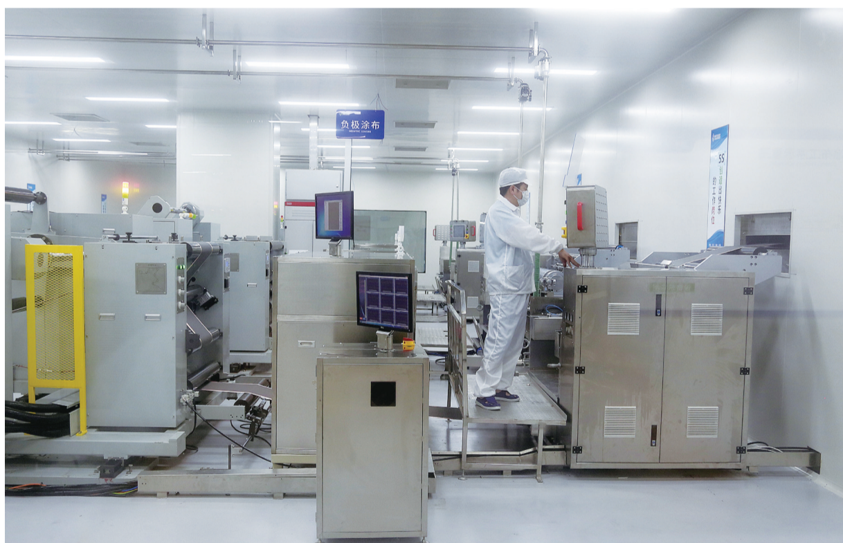
6月14日，江苏丰盈科技有限公司内，技术人员正在调试生产设备，据悉该项目由江苏云彩时代投资集团有限公司投资建设，致力于全球领先的锂离子动力电池研发、生产和PACK制造。目前5号厂房基建已经全部完成，进入设备安装的调试阶段，确保9月底完成第一条生产线投产试运营，12月完成第二条生产线的投产试运营，项目全部投产达产后，实现年开票销售45亿元、年纳税3.15亿元。 万成 摄
