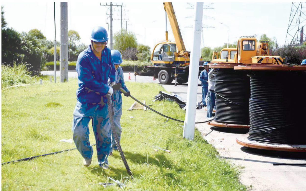
8月22日,区供电公司组织施工人员,对大丰港区20千伏大唐线1-35#杆更换绝缘导线,保证港区20多家企业安全可靠供电。 虎国华 文军 摄
