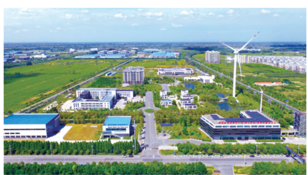
金风科技海上风电产业基地——国家战略性新兴产业（海上风电）集聚发展试点区
