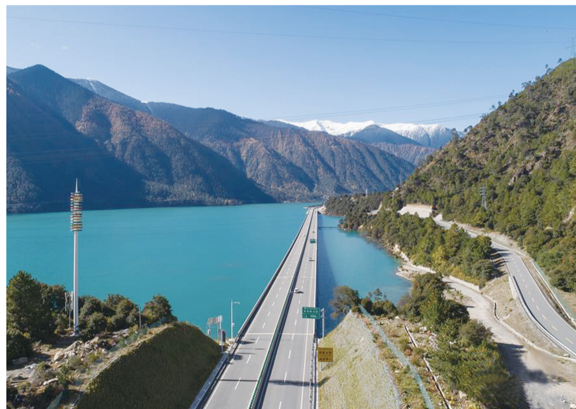
这是10月28日拍摄的林芝境内的多布特大桥(无人机拍摄)。位于西藏林芝市境内的多布特大桥被誉为拉林高等级公路上“最美大桥”。西藏拉林高等级公路起于拉萨市城关区,止于林芝市巴宜区,全长409.2公里,公路与沿途的雪山、森林、河流、湿地、村落、农田等共同构成了一幅人与自然和谐相处的美好图景。(新华)
