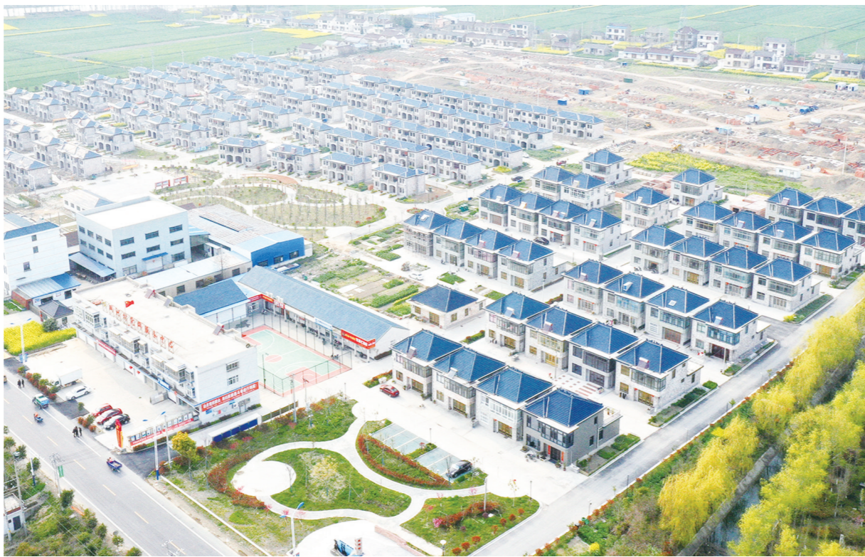
4月1日，草堰镇双河新型农村社区内，二期工程施工现场，人机协同、抢工会战，预计8月底完成目标任务。据悉，该镇今年计划迁宅进城入镇230户，留乡改善60户，一般农户D级危房改造110户，盐通高铁沿线1000米范围内“危旧破楼空散建”改造203户。
