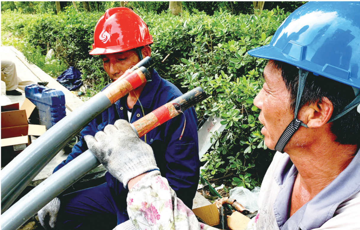
8月2日,区供电公司抢修人员冒着高温,维修更换10千伏天北线1#环网柜内真空开关。该环网柜故障导致丰华街道近千户居民失电。接到报修电话后,抢修人员立即赶赴现场,采取临时转移供电负荷方案,保障居民用电。随后,抢修人员连续作战4个多小时,第一时间恢复供电。 蔡剑涛 吴开俊 摄
