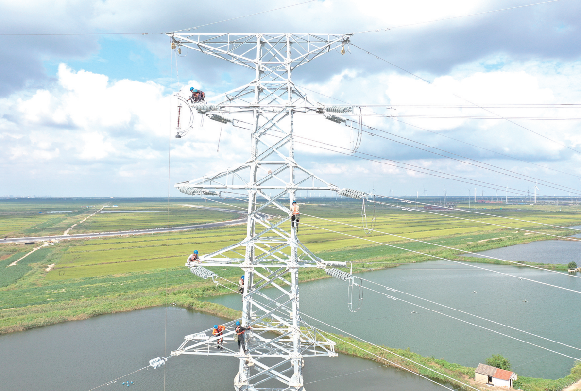
10月14日,在110千伏盐钢线建设施工现场,区供电公司施工人员对23号线路耐张塔进行紧线、跳线等工作,为大丰港经济开发区电力需求提供坚强电源保障。
