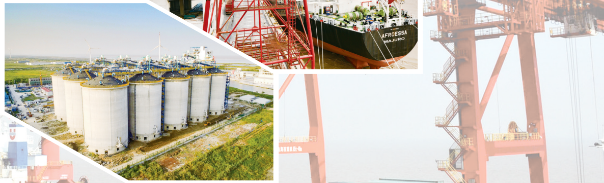
大丰港大宗农产品仓储物流项目现场
