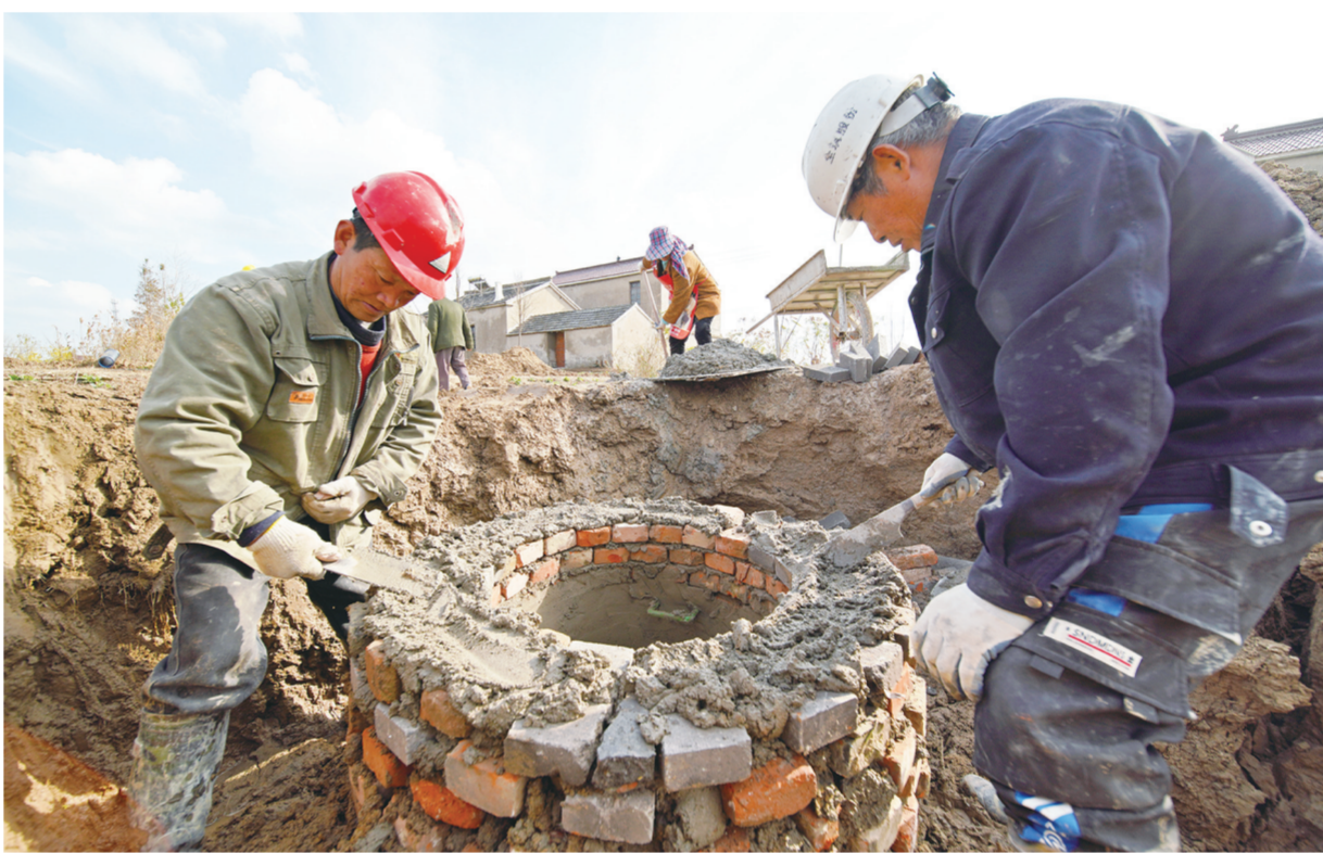
12月1日,西团镇新中村污水管网改造施工现场,工人正在砌筑管井。据悉,该镇加快推进农村生活污水治理设施建设,着力改善农村水环境。此次6公里农村污水管网改造涉及新中、北团、马港、龙窑四个村,总投资约363万元,目前已完成投资300万元。 单培泉 摄
