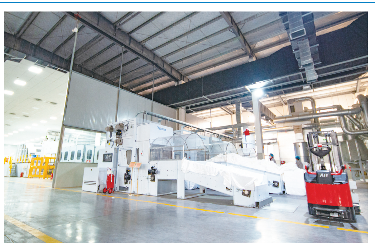
近日，江苏聚亿新材料有限公司生产车间内，工人在操作生产设备。据了解，该公司无纺新材料项目总投资5亿元，引进多条国际先进生产线，产品主要运用于医疗卫生、工业、农业、航空电子及国防等领域。目前，第二条水刺无纺布生产线正在安装调试，完全投产后，可日产水刺无纺布20吨以上。 单培泉 摄
