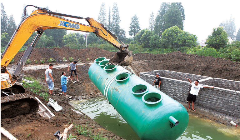
农村生活污水管网通到家家户户
