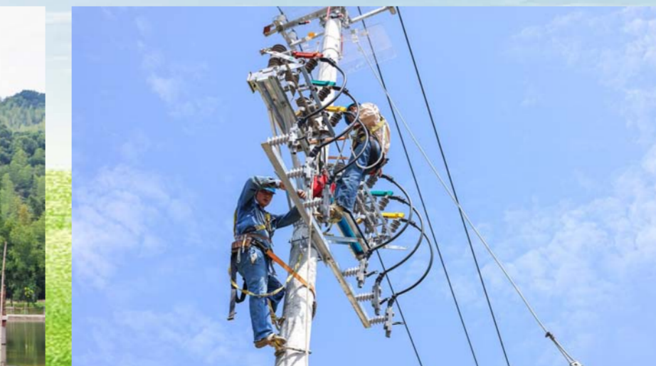
电力工作人员正在进行高压配电网设备安装，做好110千伏上柏变电力送出工程。(姜涛 摄)
