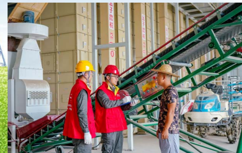
电力红船党员服务队在洛舍镇先锋农机开展用电安全检查，保障用电可靠。(陈研宏 摄)
