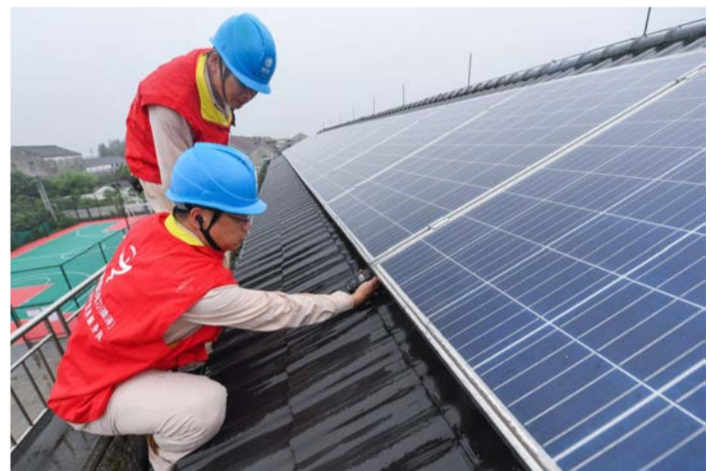
电力工作人员正在新安镇合东村检查屋顶光伏接入情况，服务清洁能源消纳。(徐呈 摄)
