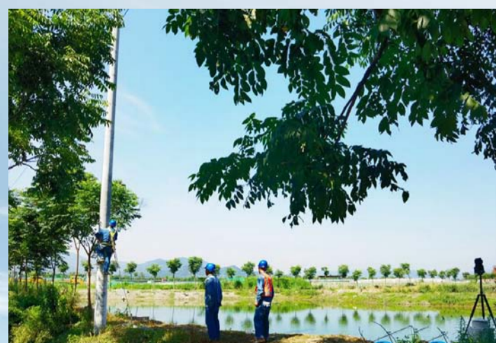
电力工作人员在工程建设现场应用数字化安全管控智能终端，提高工程安全和管理。(姜涛 摄)
