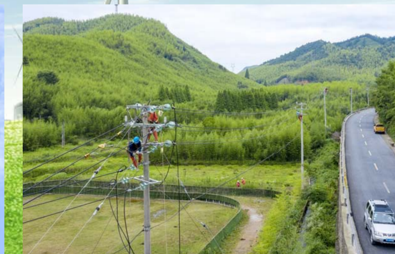
电力工作人员正在进行10千伏南路架线建设，服务山区经济发展用电需要。(陆晓峰 摄)
