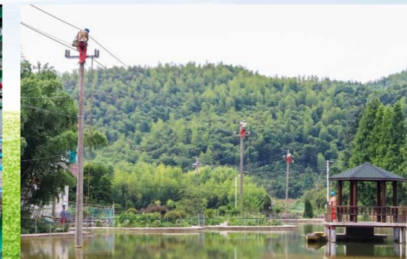
电力工作人员正在下渚湖街道开展10千伏线路绝缘化改造，提升供电可靠性。(宋贤良 摄)
