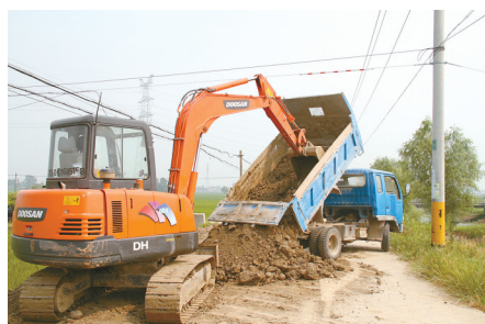
入夏以来,梁垛镇抢抓早晚时间,加快农村公路提档升级工程建设。图为殷樊线农村公路拓宽改造施工现场。
