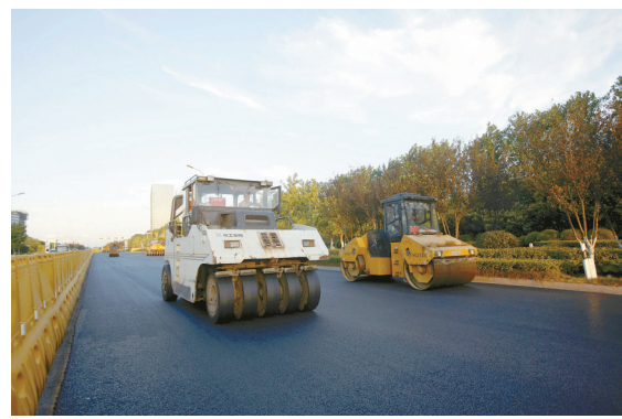
东进大道改造工程已经进入沥青摊铺阶段,图为8月24日傍晚施工现场。记者 徐越峰 摄
