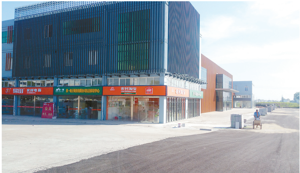
安丰镇利用原义鸟小商品城打造全新的电商产业园,被评为盐城市电子商务示范园区。目前已有12家电商企业、5家物流企业入驻。图为电商产业园施工现场。记者 戴海波 摄
