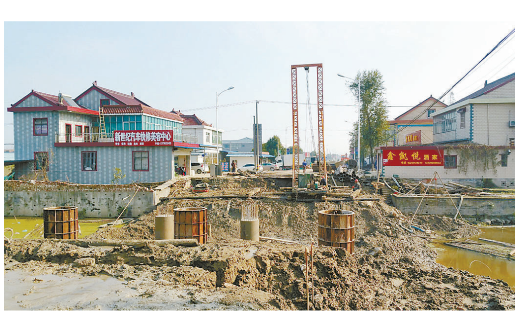
富安镇积极争取项目资金，对沿海高速富安出口至老204国道段进行路桥改造，提升园区配套能力，方便群众安全出行。图为富安工业园区安乐桥施工现场，预计明年1月底完工。记者 戴海波 摄
