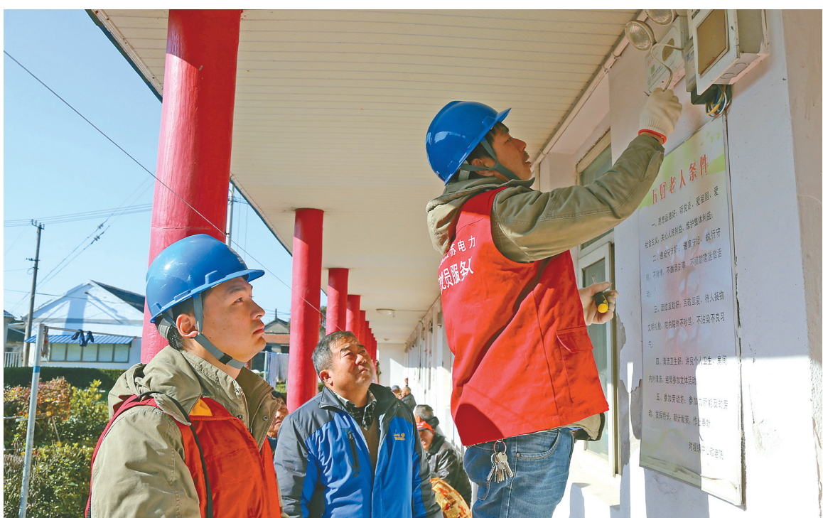
日前，市供电公司时堰供电所员工到该镇中心敬老院进行安全用电检查，确保老人春节用上安全、舒心电。 陈娟 孙永兴 摄
