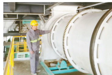
源耀生物科技有限公司新上酵母微量元素复合制品项目,目前已进入调试阶段,预计 5 月可投产。曹燕妮 徐良观 摄
