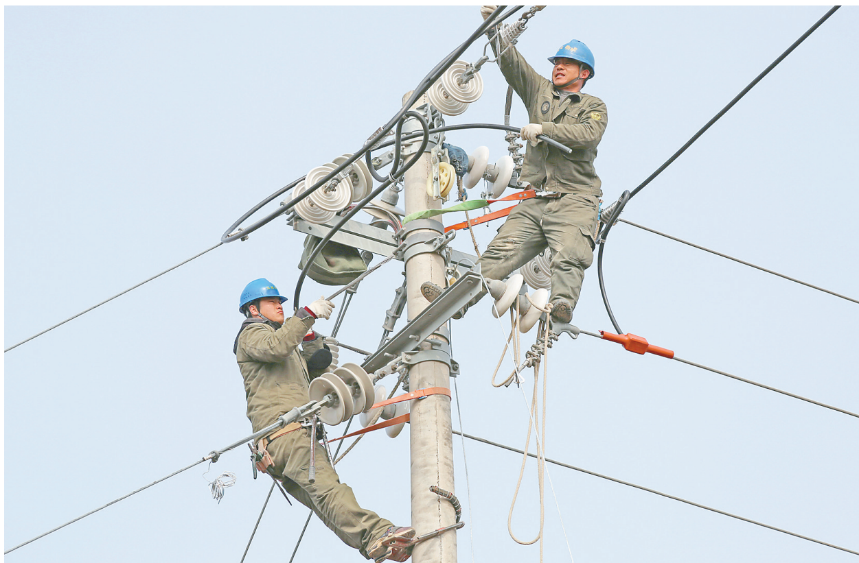
1月18日，市供电公司组织施工人员改造东台镇10千伏海堤线，将原120平方毫米的裸导线更换成240平方毫米的绝缘导线，提高海堤线供电质量，保证渔民养殖用电安全。记者 唐雅 通讯员 孙永兴 摄
