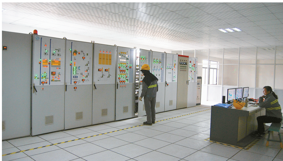
位于南沈灶镇的源耀生物科技有限公司注重产品研发,发酵技术不断更新。2017 年该公司完成开票销售 7.8 亿元,入库税金 1354 万元,创成“盐城市现代农业五星级龙头企业”。今年公司计划投入 500 万元,用于设备自动化改造,进一步提升自动化程度。图为生物三车间中控室。徐良观 摄
