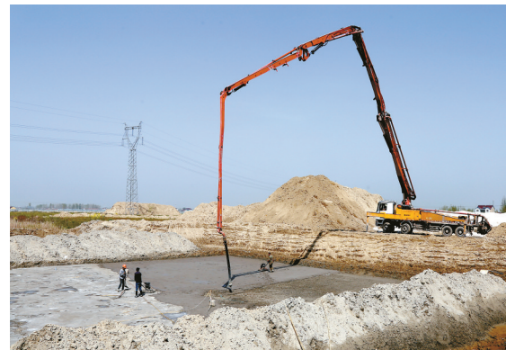
头灶镇聚宝湖农业创意园规划打造高效农业示范区、阡陌田园观赏区、水上乐园休闲区等6个工程区。图为该园高密度养殖鱼塘施工现场。记者 戴海波 摄
