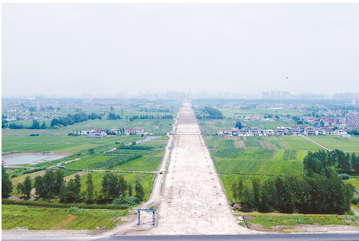
海陵路南延是城市向南的重要出口通道,北起海陵路与惠阳路交叉处,南至610省道,按照双向六车道一级公路标准建设。目前,工程正按序时快速推进。 刘进涛 摄
