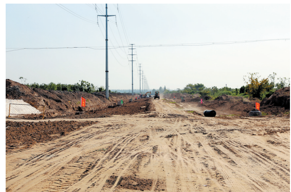
新街镇围绕特色产业,依托长1.1公里的府前路东延路段,规划拓展1000亩工业园区,不断做大海洋工程特种装备产业园区。图为府前路东延施工现场。记者 戴海波 摄
