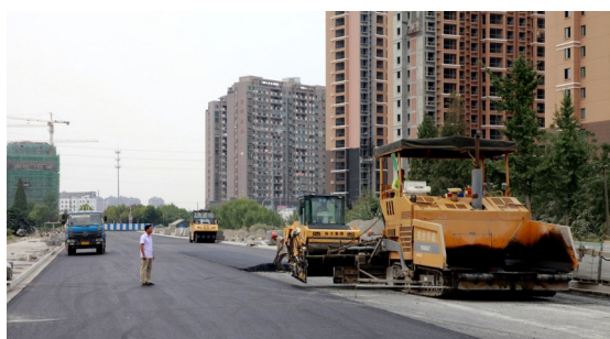
图为经六路工程建设现场。
