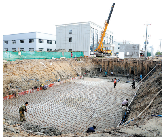
三仓镇以开展园区基础设施提升年活动为抓手,强化园区基础设施配套功能,建成投运工业污水处理厂,实施天然气管道工程,提升园区项目承载力。图为施工单位正在进行污水处理项目施工。记者 王灿侠 通讯员 沈永红 摄
