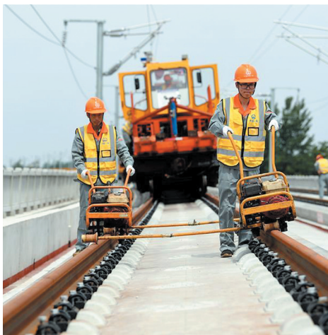
6月11日,中铁一局新运公司施工人员在 1 进行铺轨作业。当日,郑阜铁路最后一对500米长钢轨在安徽阜阳铺设完成,标志着郑阜铁路全线铺轨贯通。郑阜铁路连接河南郑州与安徽阜阳,全长267公里,设计时速为350公里,预计2019年底建成通车。
